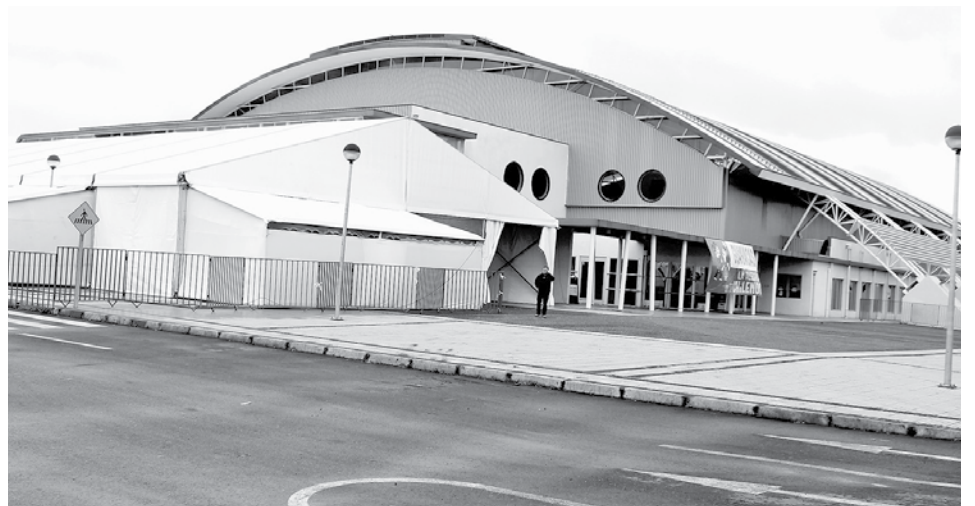
ACUSAN QUE estas organizaciones deterioran el recinto con su uso, sin que haya contraprestación a cambio.
