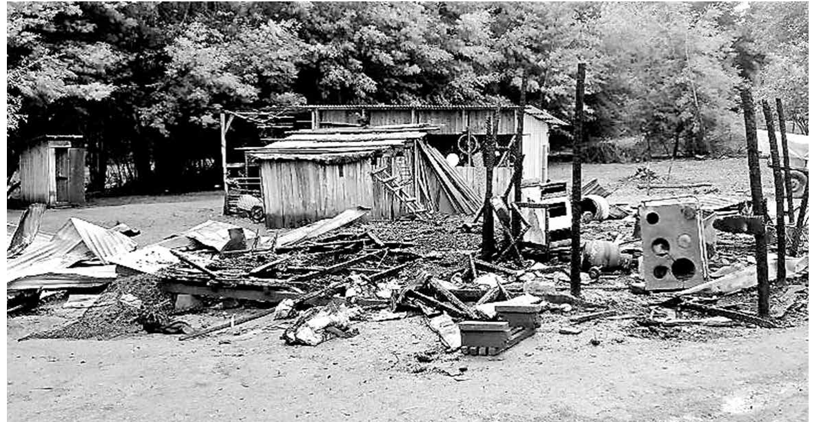
PESE AL ESFUERZO de Bomberos, la vivienda de material ligero resultó completamente consumida producto de las llamas.
