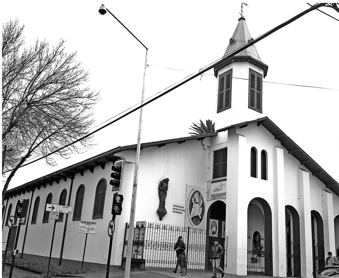
LA IGLESIA FUE CONSTRUIDA EN 1800 y pese a los terremotos de 1960 y 2010, aún continúa en el mismo lugar.
