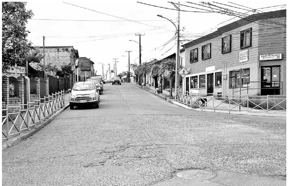
LAS OBRAS DE PAVIMENTACIÓN se suman a las que, actualmente, se están ejecutando en calle Baquedano en Nacimiento.
