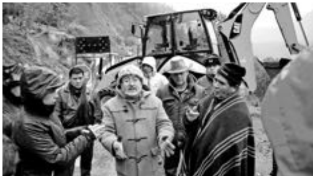
EL GOBERNADOR, LUIS BARCELÓ, visitó durante la mañana del lunes el puente colapsado.
