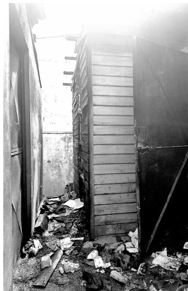
LA BODEGA AFECTADA resultó completamente destruida por las llamas.
