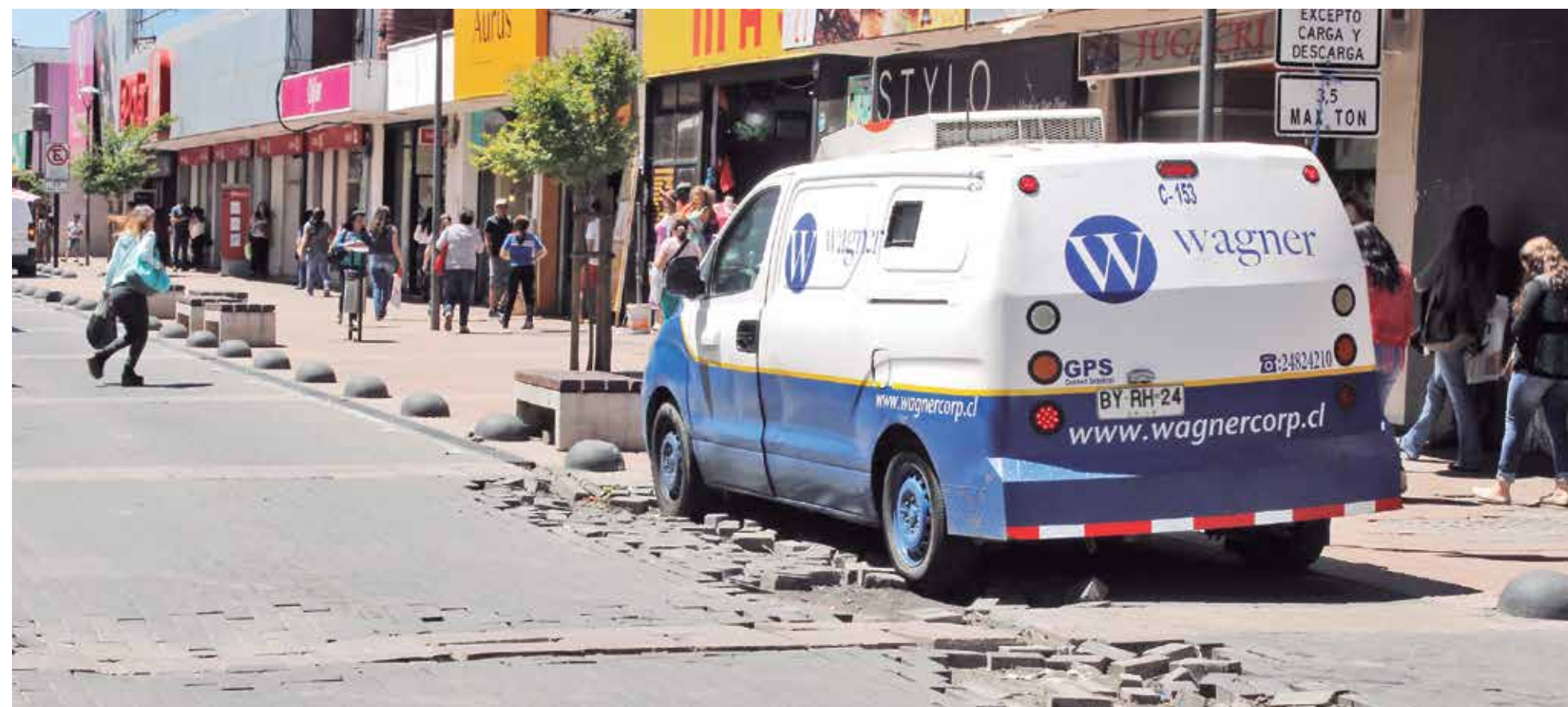
PROYECTO CONTEMPLA realizarse en tres etapas de cierre de calle Colón.
