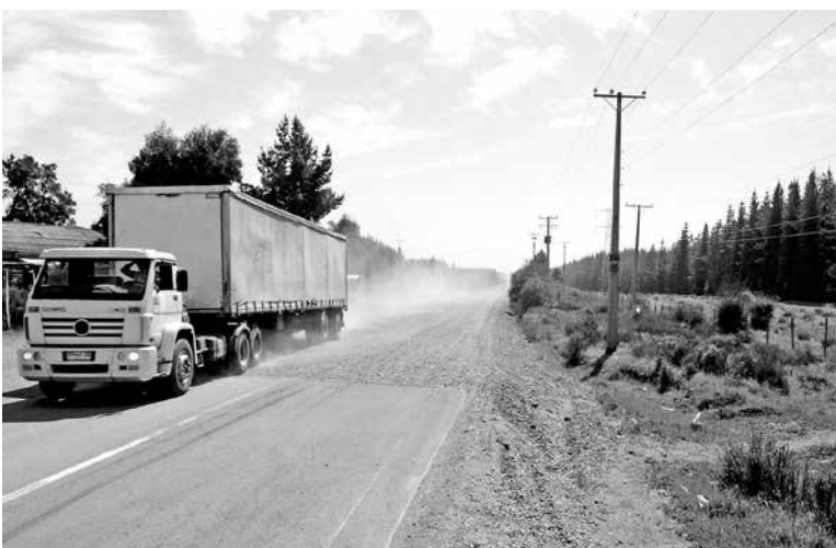
RECORDEMOS que la Ruta Q-20 se ejecutará en 2 etapas, comenzando las obras en sus extremos.
