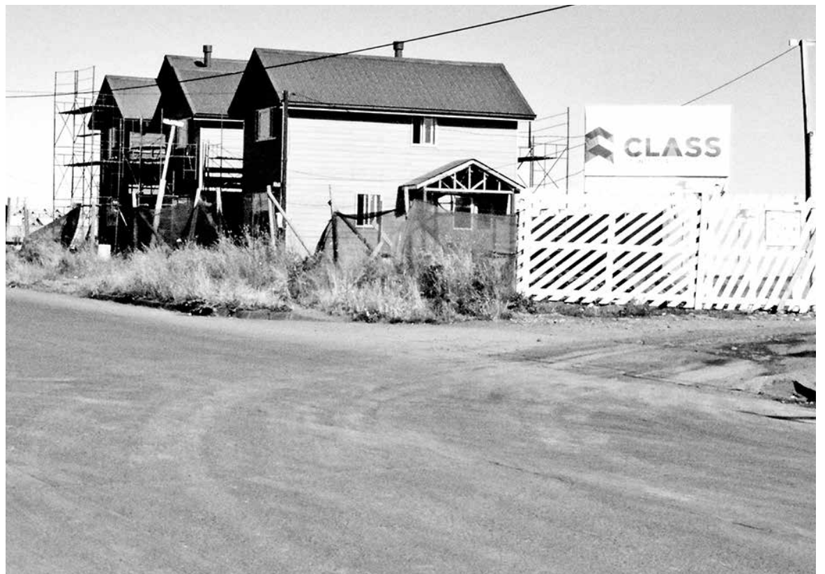
EL DELITO AFECTÓ a una empresa constructora ubicada en avenida Lauquén, en Los Ángeles.
