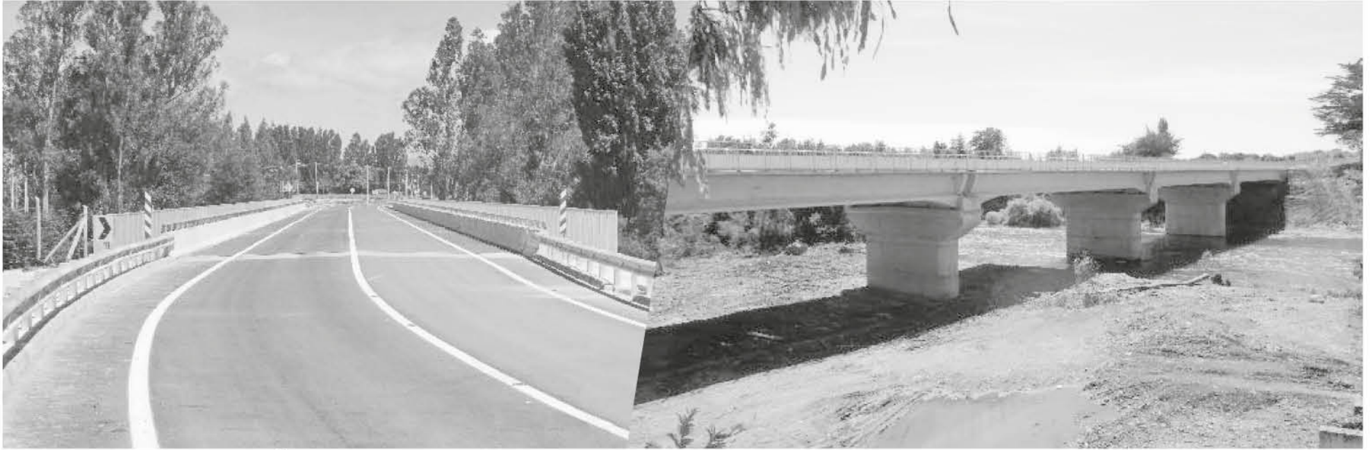
EL PUENTE TUVO UNA INVERSIÓN de MM$4.982 y se ejecutó en un plazo de 540 días.
