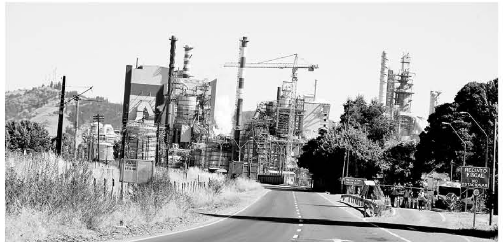
PARA EVITAR UN NUEVO EPISODIO, la empresa celulosa realizó un convenio con la municipalidad de Laja.
