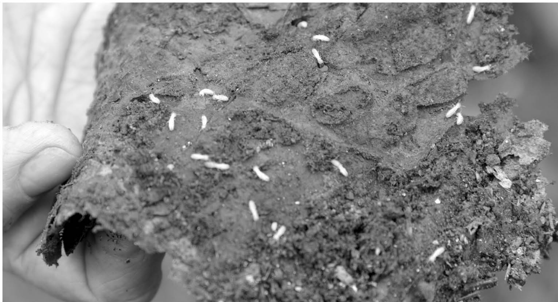
SON MIL 400 LAS FAMILIAS afectadas por las termitas en el sector, donde finalmente se instalarán 5 mil cebos con veneno.
