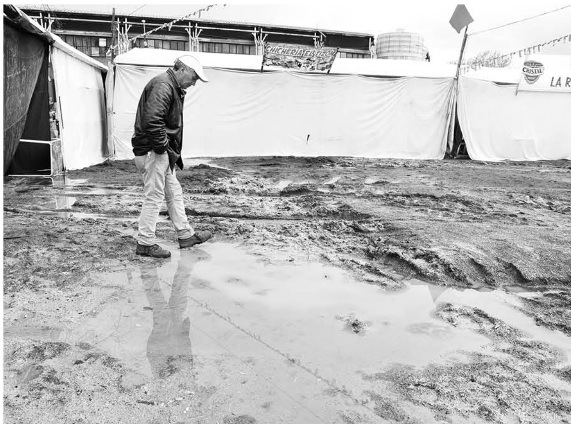
LAS LLUVIAS IMPIDIERON el funcionamiento normal de las ramadas durante septiembre.
