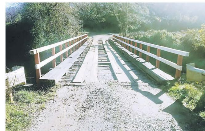
VIEJAS ESTRUCTURAS DE MADERA han ido reemplazando los puentes mecánicos instalados.
