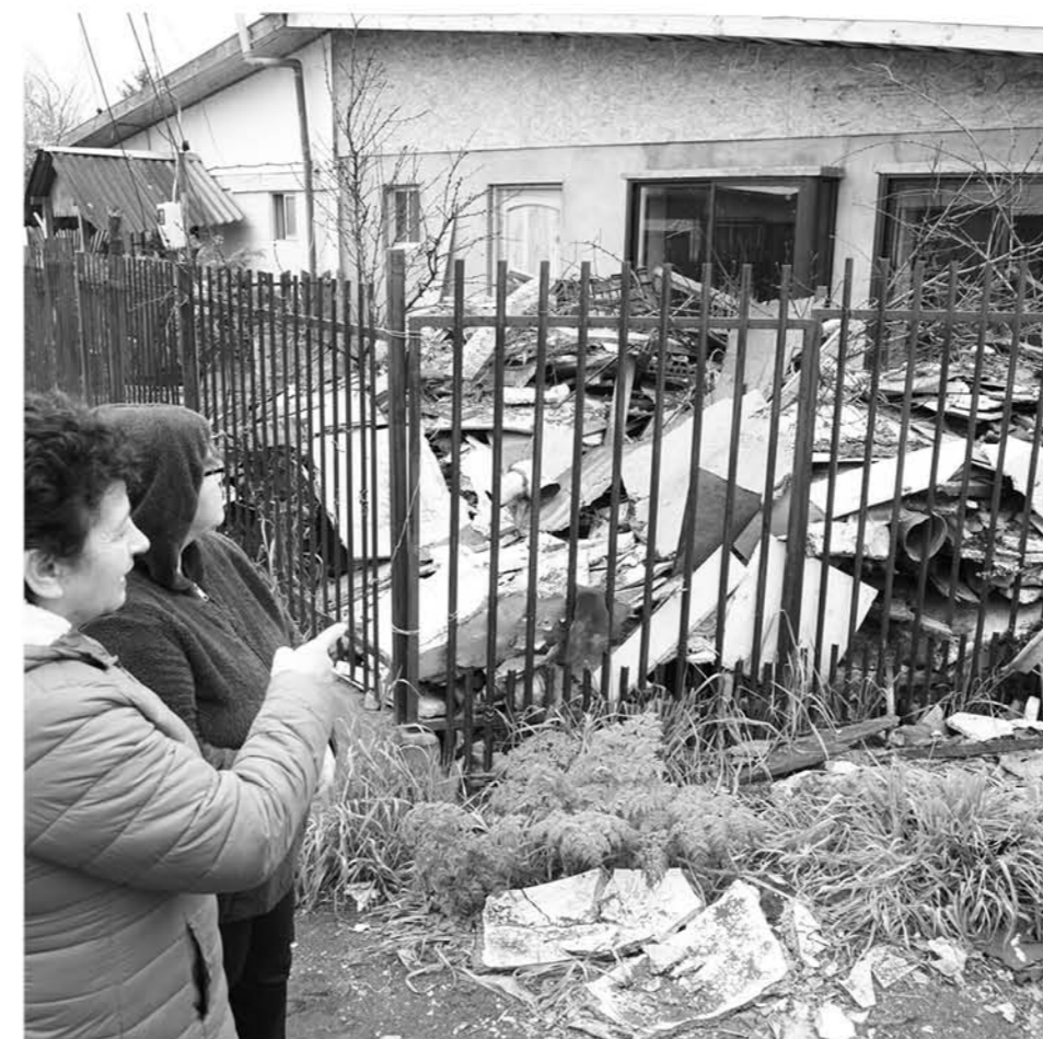
La presidenta y tesorera de la junta de vecinos de la población Entre Ríos muestran una de las viviendas que tuvo que ser reconstruida en el sector a causa del accionar de las termitas.
