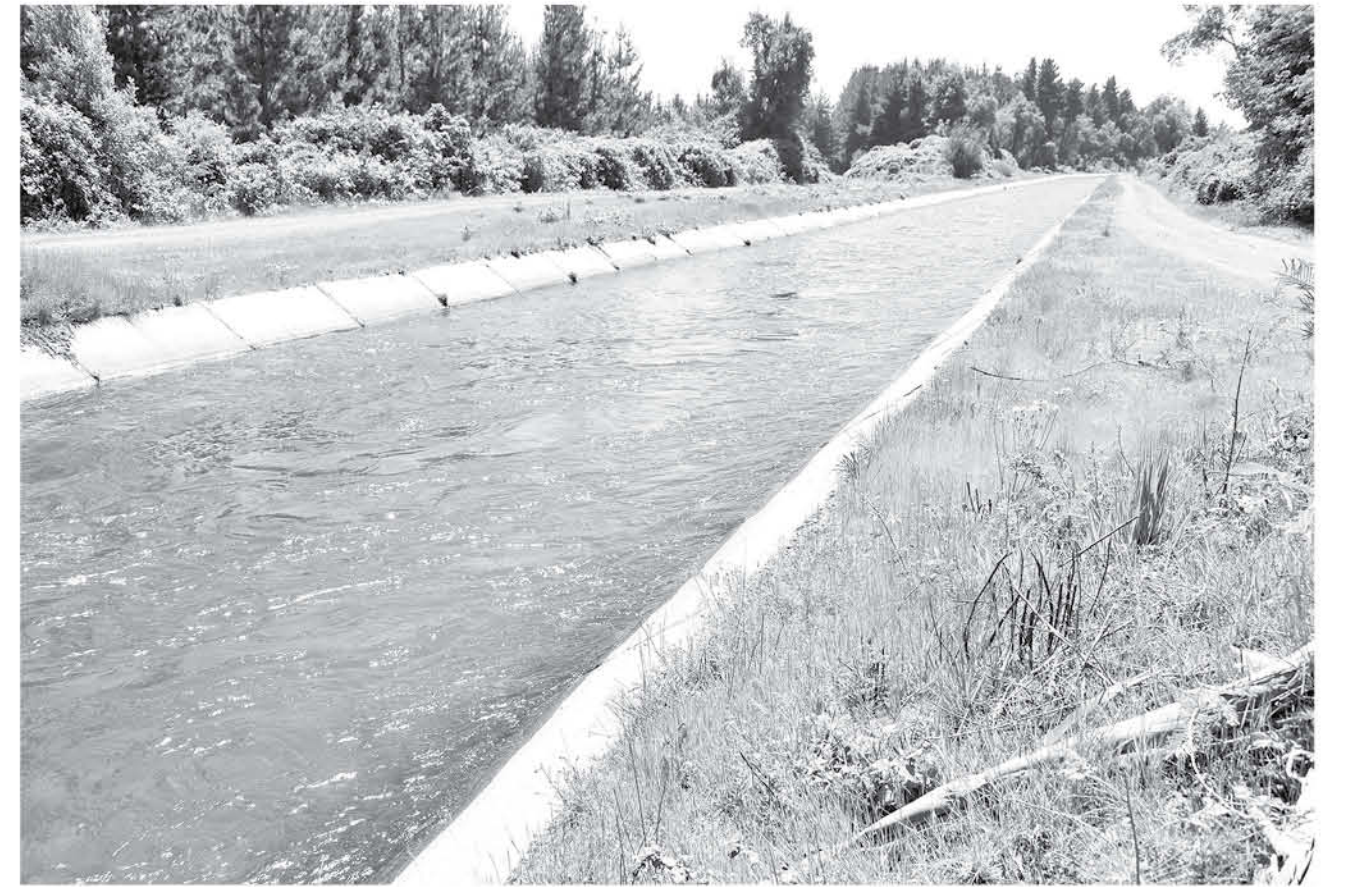
LA INICIATIVA CONTEMPLA construir una carretera que traslade agua desde afluentes cordilleranos ubicados en la provincia de Biobío hacia el norte del país.
