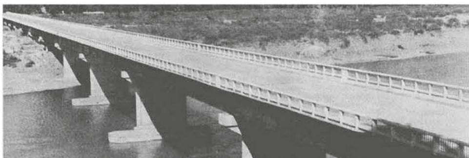
PUENTE COIGÜE, 1965. Su construcción hizo desaparecer progresivamente los balseaderos como el de Negrete.
