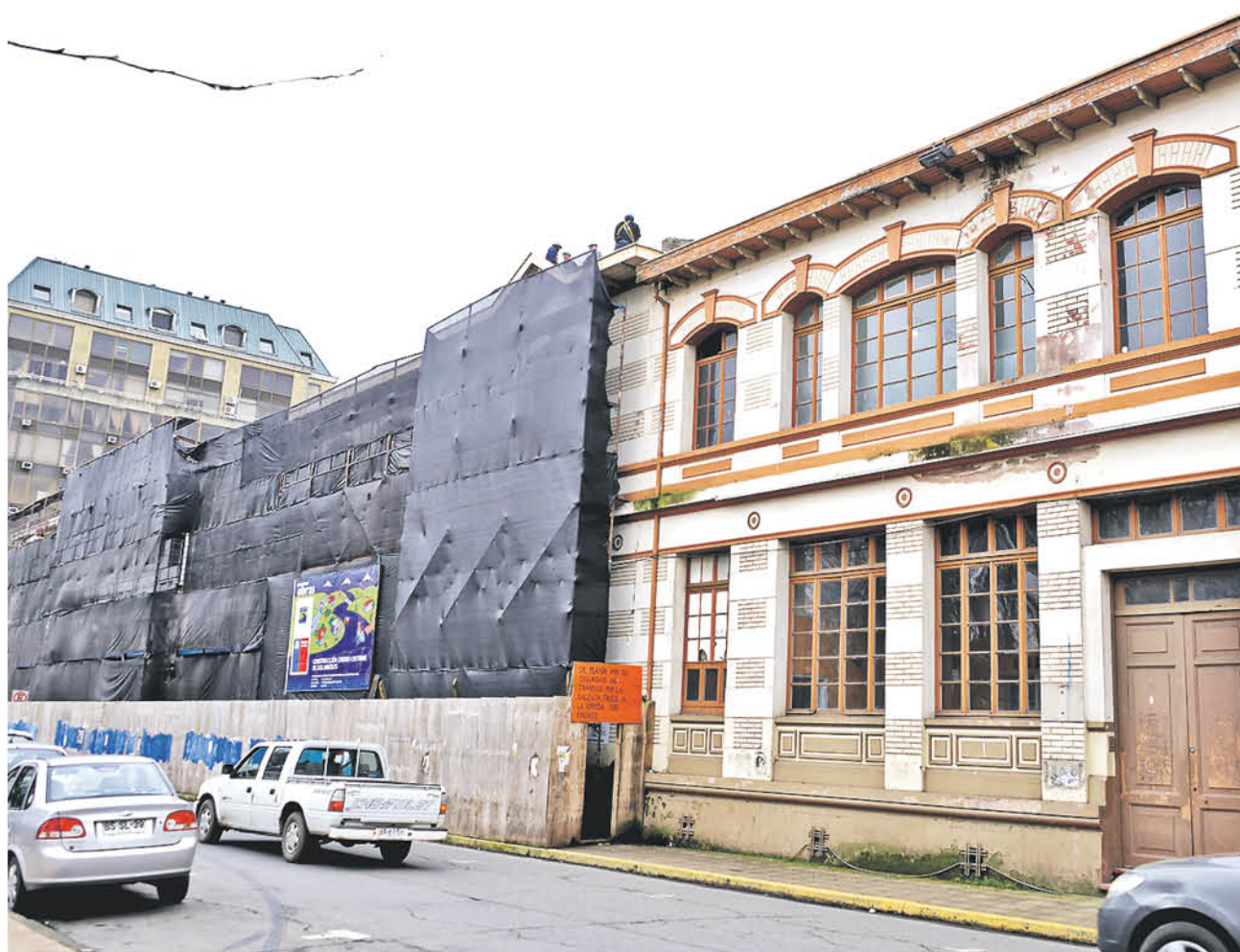
EN LOS PRÓXIMOS DÍAS se debería conocer la resolución del Tercer Tribunal Ambiental de Chile, respecto a la posibilidad de continuar con los trabajos de construcción del Centro Cultural que hasta el momento ostenta más de un cincuenta por ciento de avance a pesar de todos los imprevistos que ha enfrentado en el último período.
