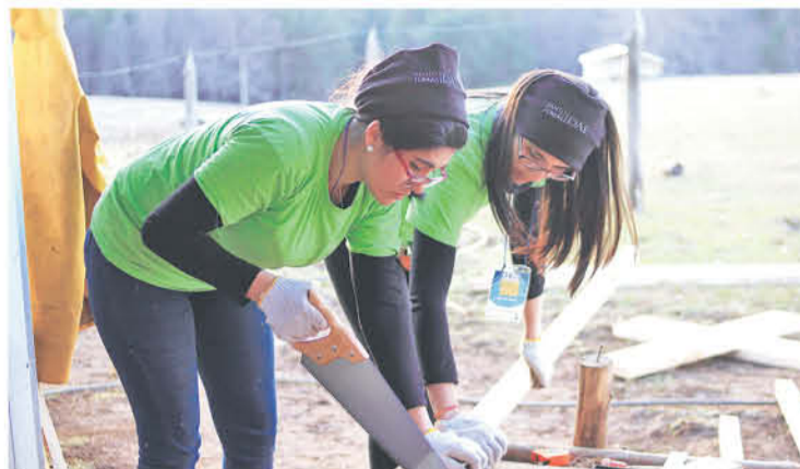
VOLUNTARIOS TRABAJAN PRINCIPALMENTE en la instalación de mediaguas y revestimiento interior de las viviendas.
