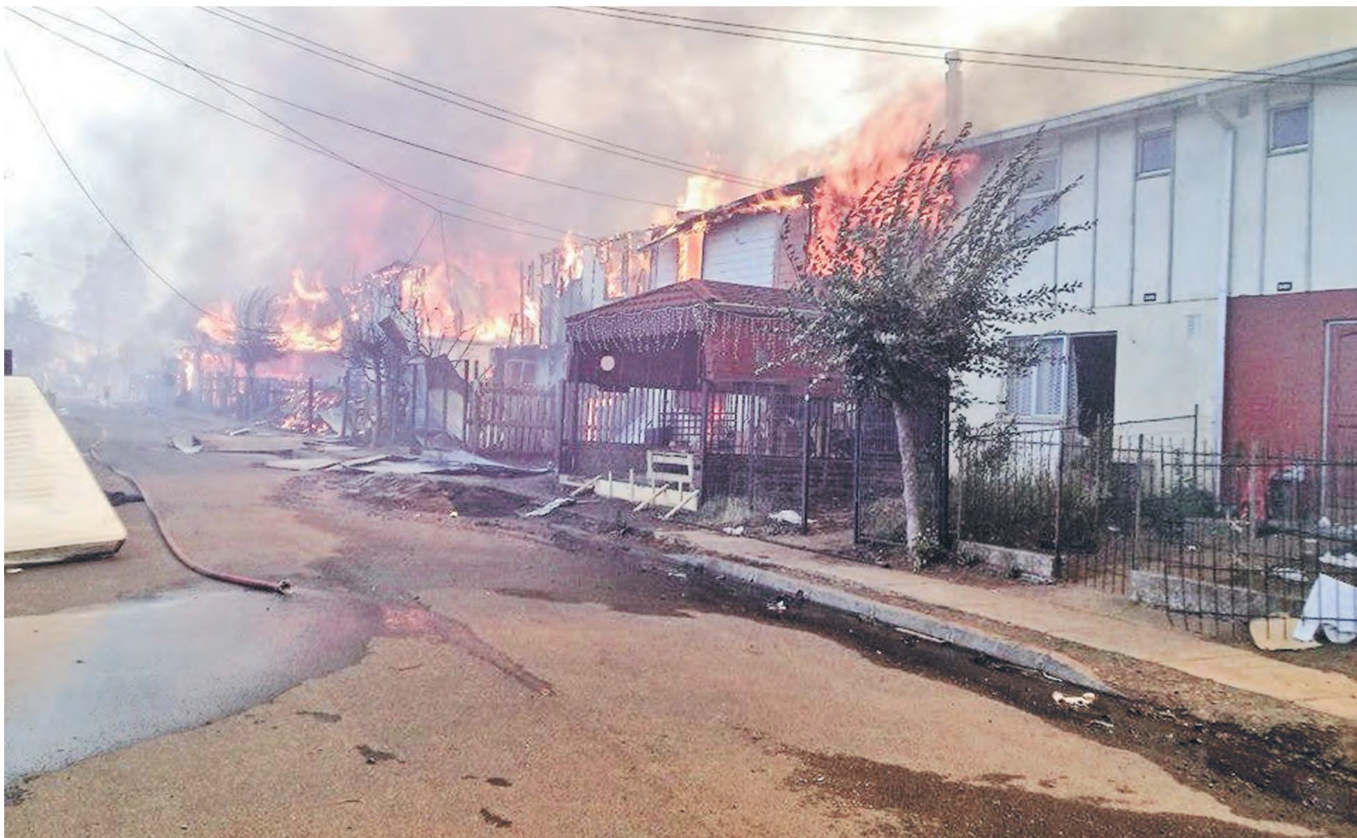
15 CASAS RESULTARON DETERIORADAS producto de las llamas; 12 de ellas totalmente destruidas y las otras tres con daños de consideración.
