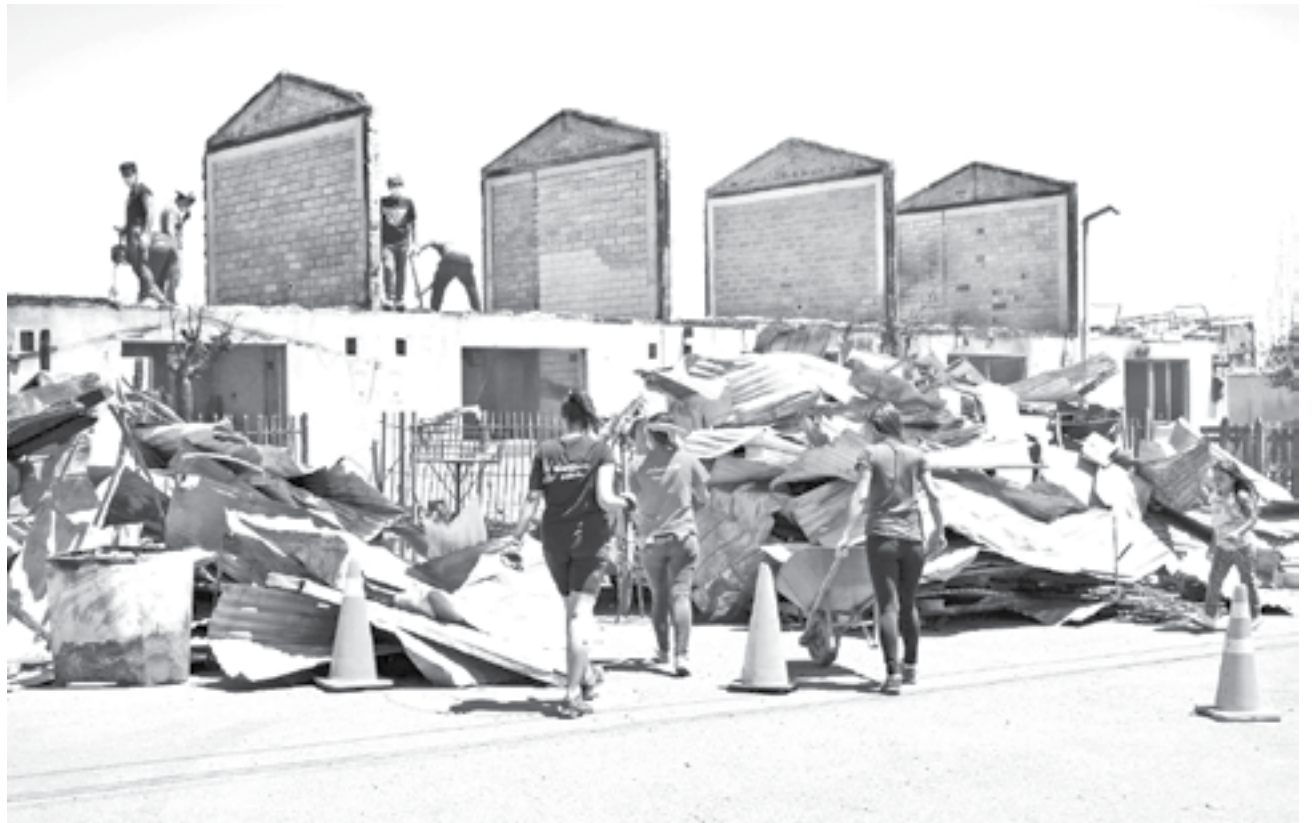
LA JORNADA DE AYER en villa Rehuén estuvo marcada por los trabajos de remoción de escombros.
