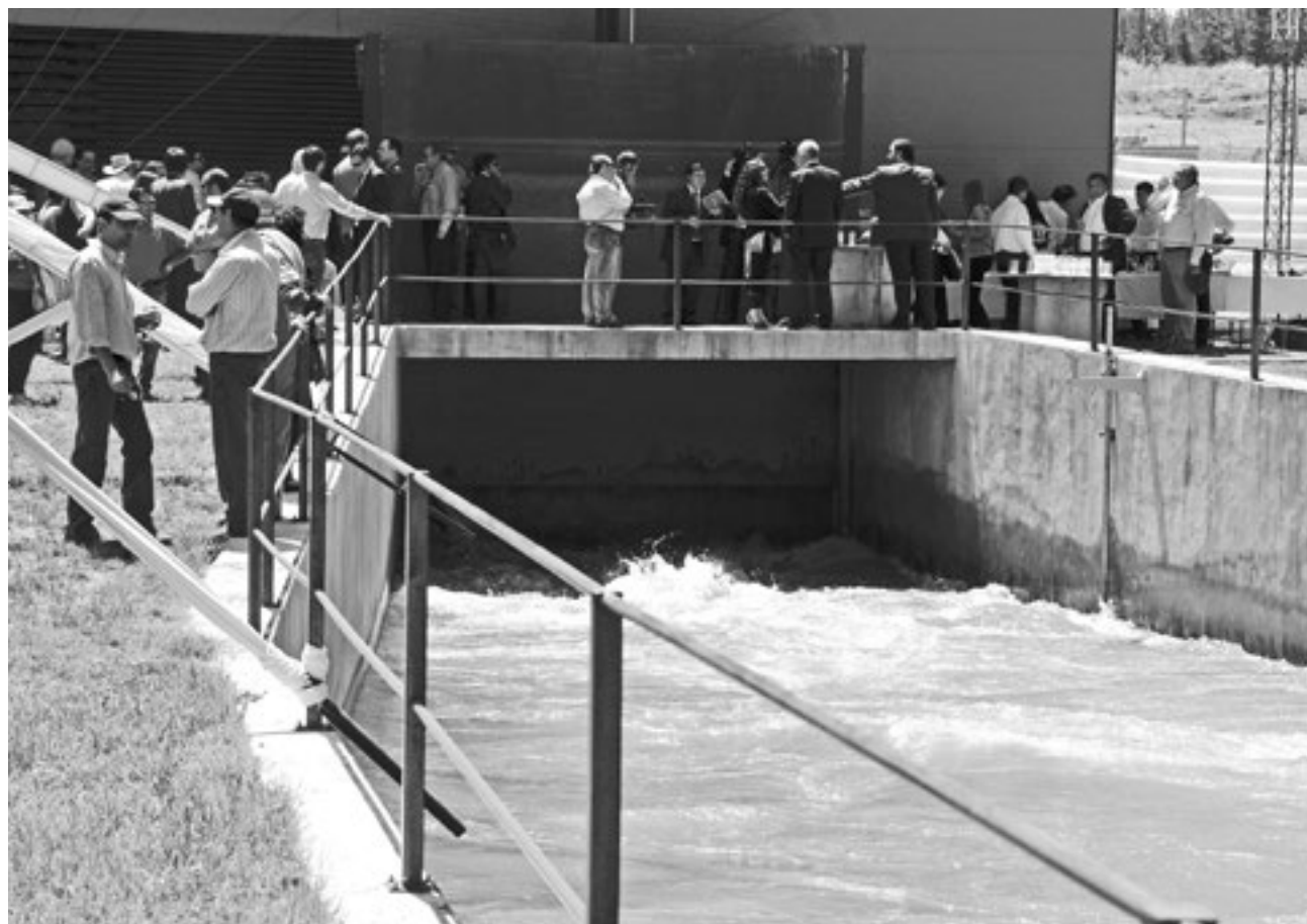
MINI CENTRAL HIDROELÉCTRICA de Canalistas del Laja.
