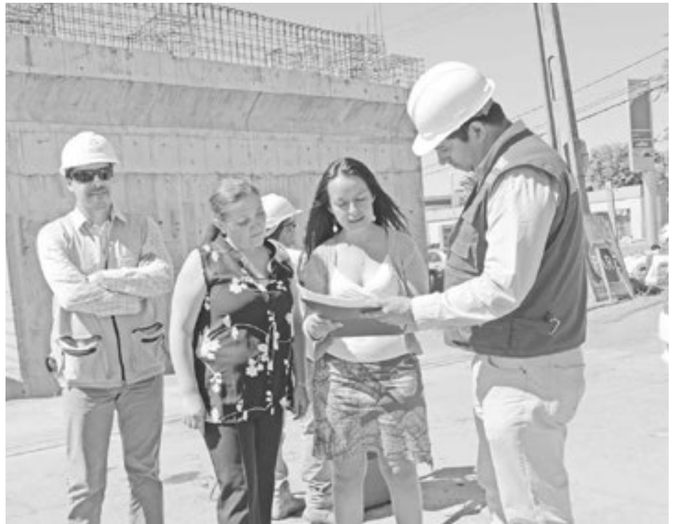
A MEDIADOS DE ENERO se dio el vamos oficial al reinicio de los trabajos en el paso sobre nivel.
