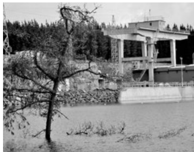
CENTRAL HIDROELÉCTRICA de pasada en el río Laja.
