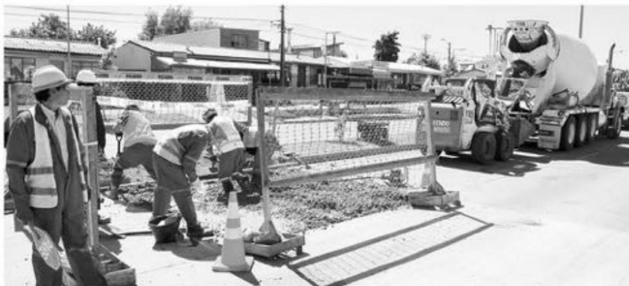
LOS TRABAJOS consisten en la instalación de una tubería con un diámetro de 450 mm y una longitud de 2.700 metros. (Fotografía cedida)
