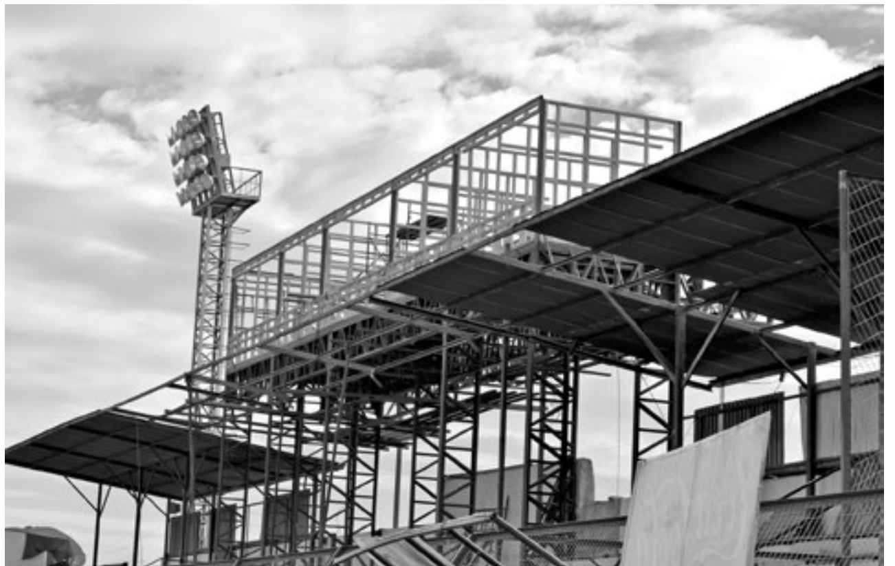
ESPACIO PARA LAS TRASMISIONES del CDF aún sin terminar.
