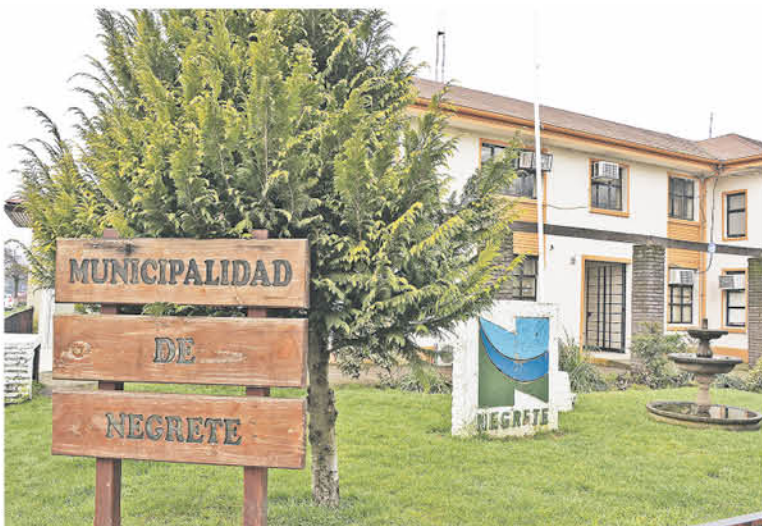
LA EMPRESA CUESTIONADA, Bio Casa, estuvo a cargo de las obras del proyecto habitacional "Vamos por una vivienda I y II" en Negrete.
