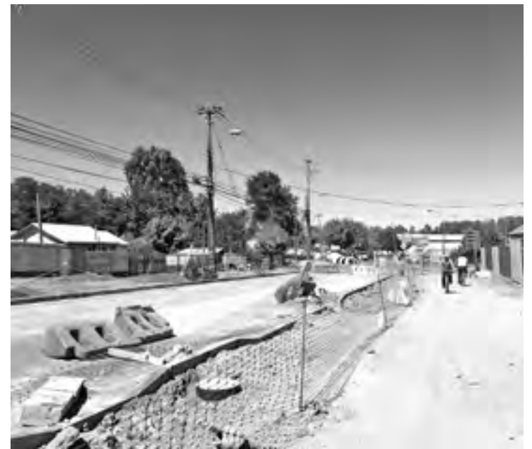
LOS TRABAJOS han generado variados desvíos de tránsito.
