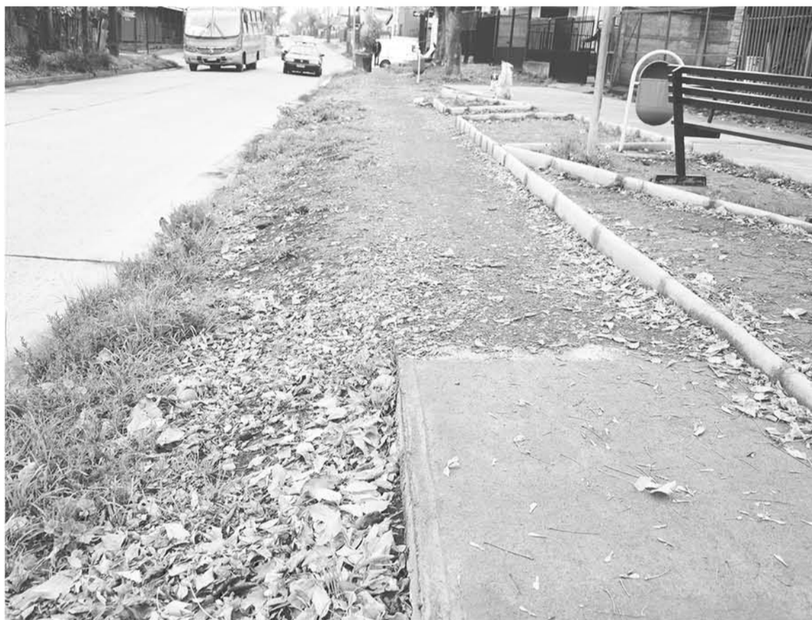
ESTE ASPECTO PRESENTA hoy la calzada para peatones en calle Galvarino, entre Laguna del Laja y Villarrica, en la población Lagos de Chile.
