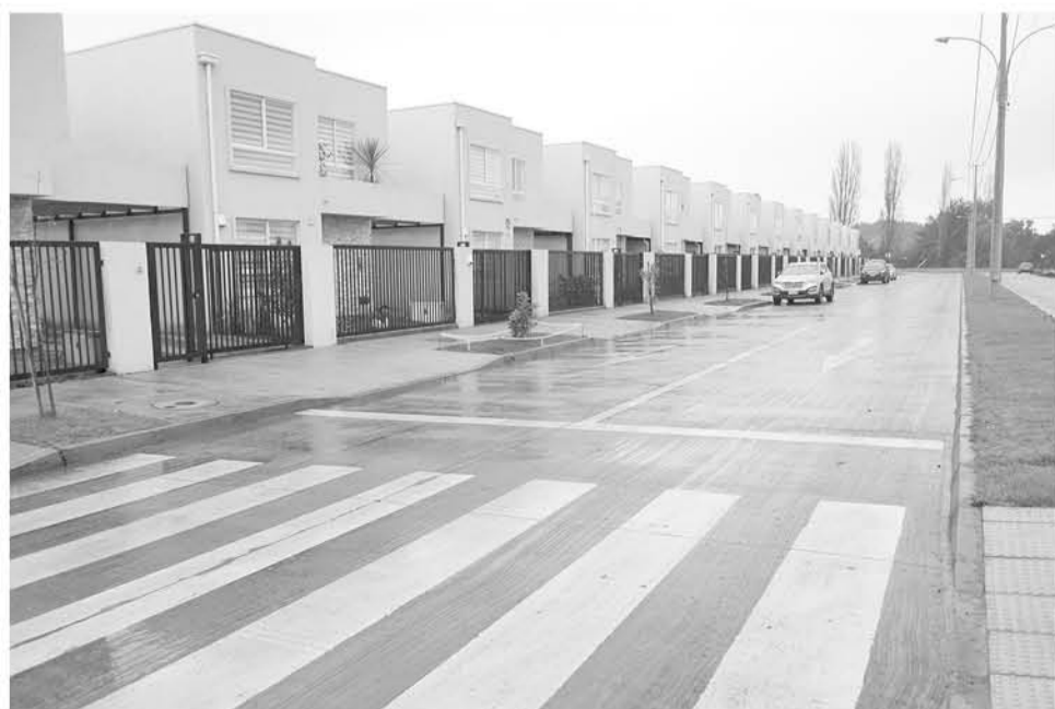
CADA VEZ QUE LLUEVE comienza la angustia de los afectados.
