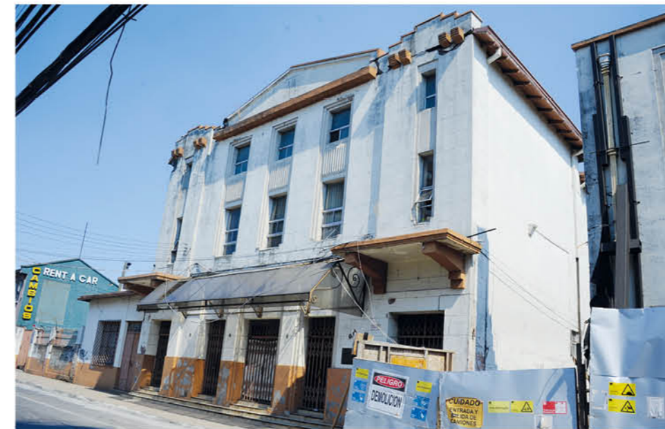
ACTUALMENTE edificio en abandono.
