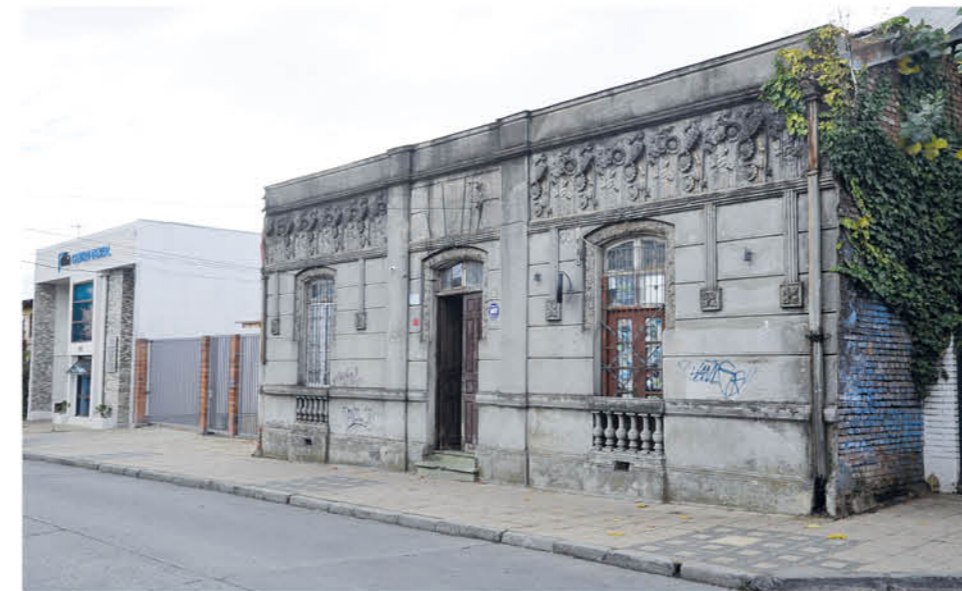
ACTUALMENTE la fachada ha sufrido el abandono de sus dueños.
