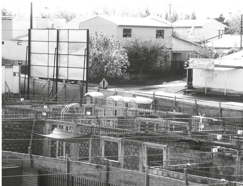
EMPRESA EHITUS indica que una vez que Junji tomó posesión de las obras no les permitieron sacar sus cosas.
