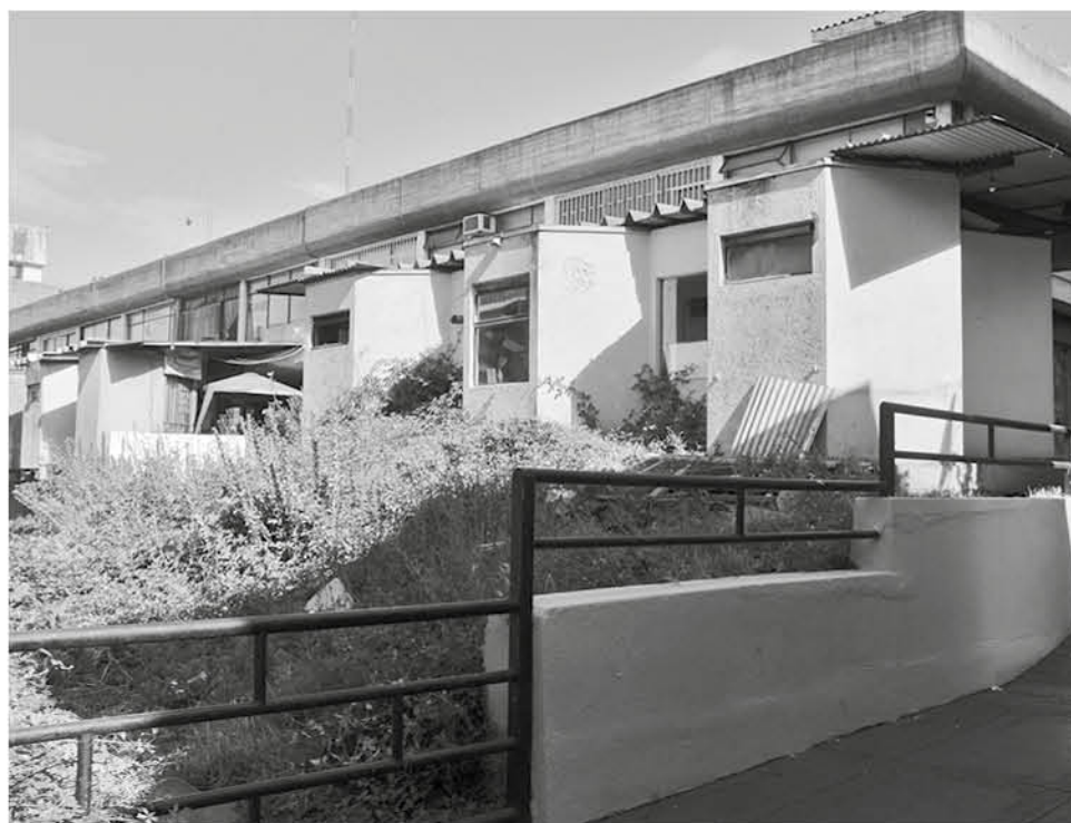
ESTE ES EL ASPECTO que presentaba este jueves por la tarde la parte posterior del edificio Pedro de Córdoba y Figueroa, en el centro de Los Ángeles.
