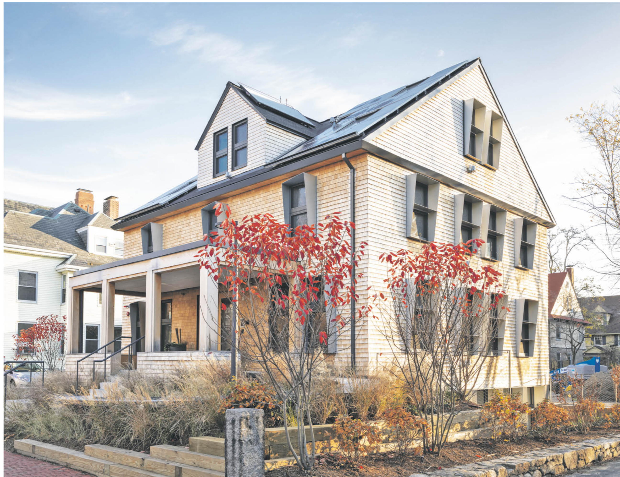
UNA VISTA DE LA CASA SUPEREFFICIENTE que está siendo un laboratorio para las próximas casa verdes de los próximos años. (Foto cedida por Snøhetta).
