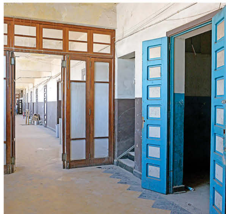
EL TERCER PISO del remodelado edificio se mantiene intacto.
