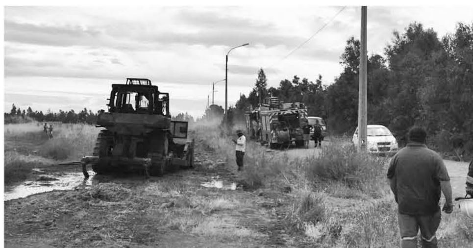
EL TRABAJADOR AFECTADO se encontraba realizando trabajos de remoción de escombros a la hora del incidente.
