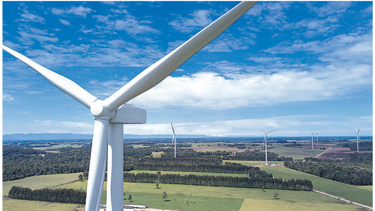
MAINSTREAM ES LA TRANSNACIONAL responsable de la construcción del Parque Eólico Alena.
