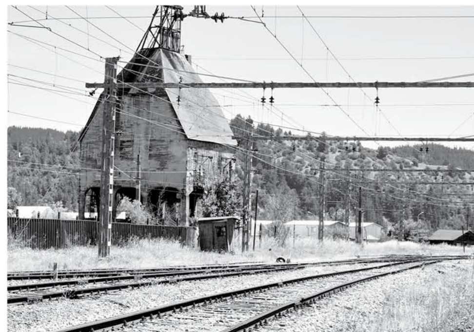
LA SALA DE MÁQUINAS DE SAN ROSENDO es un ejemplo de la imposibilidad que tienen los municipios para trabajar las propiedades de EFE.
