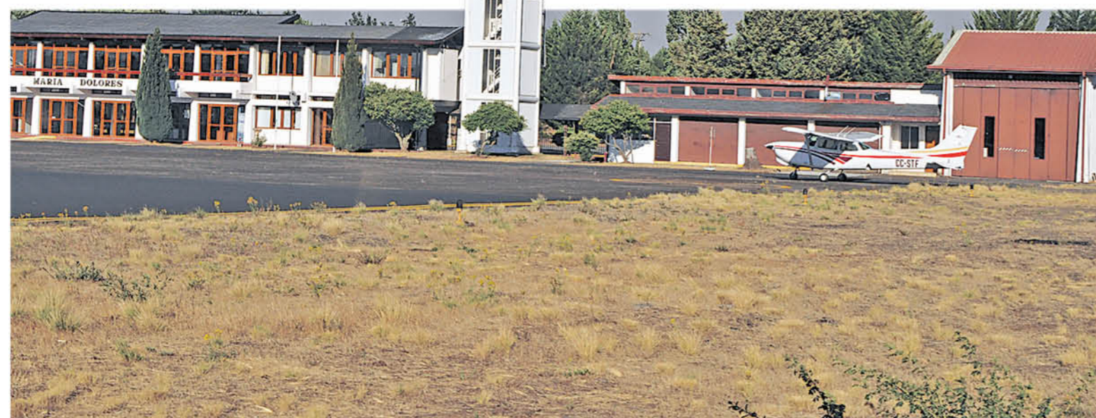
LA TORRE DE CONTROL fue reinaugurada tras el terremoto del 2010 y cuenta con tecnología que permite los vuelos comerciales.
