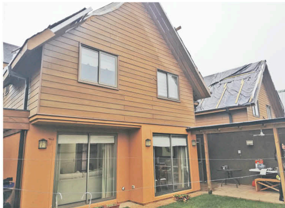
EL TECHO DE LA CASA de Eliana Duran fue de los más destruidos por el tornado
