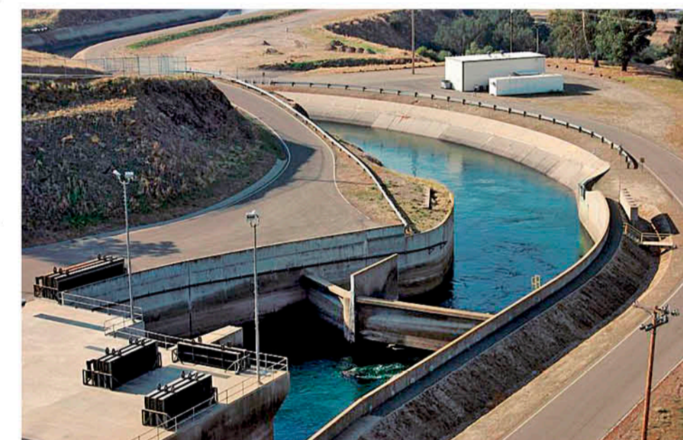
EL PROYECTO TERRESTRE considera una gran cantidad de construcciones para empujar el agua hacia el norte.
