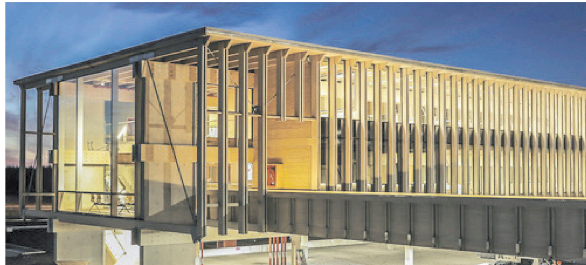
EL EDIFICIO DE CMPC EN LOS ÁNGELES es un claro ejemplo de que en Chile se puede construir en madera con las últimas tecnologías y a un altísimo estándar de calidad.
