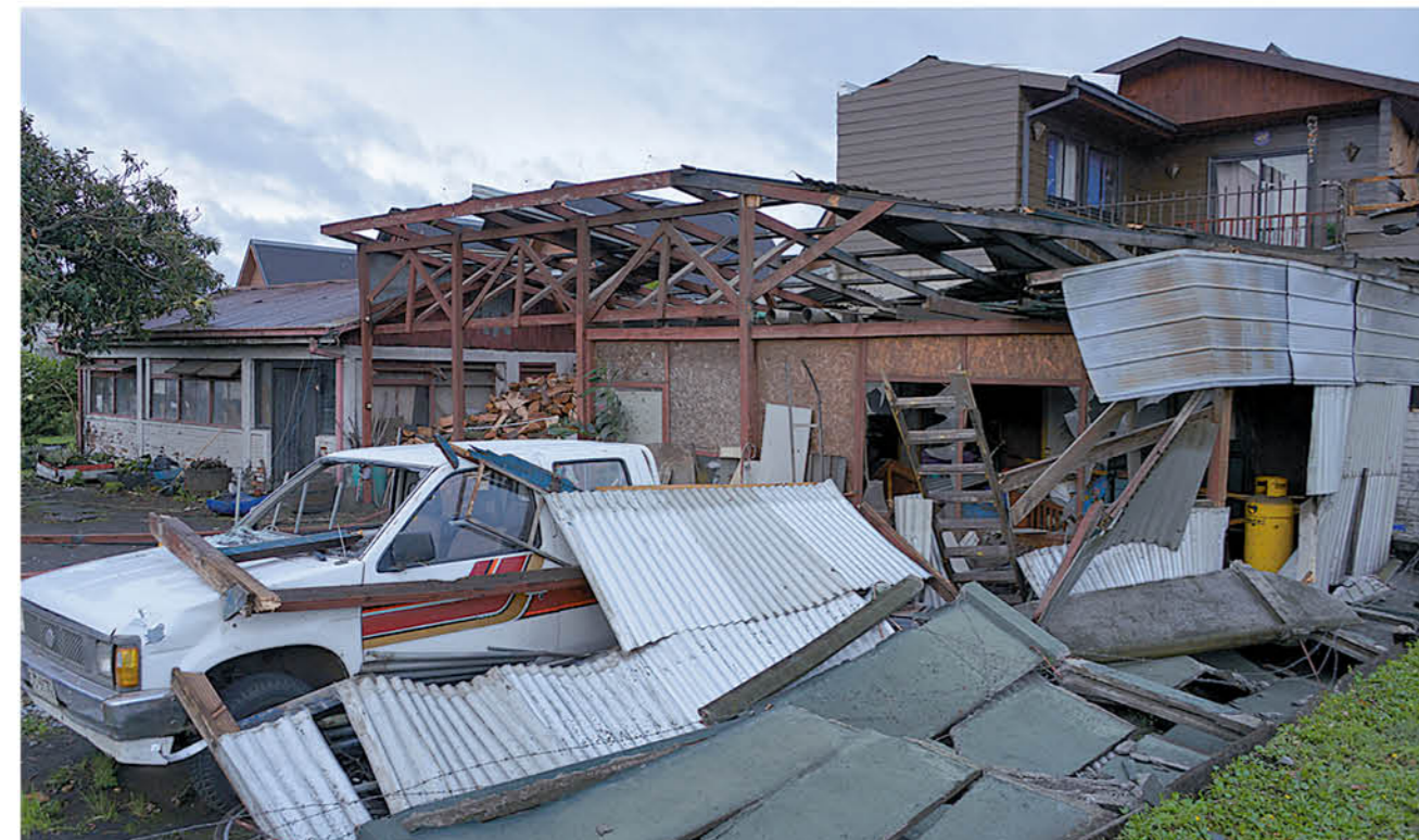
EL TORNADO REGISTRADO en mayo último en Los Ángeles, alcanzó una intensidad EF-2 en la escala de Fujita mejorada, lo cual se traduce en vientos máximos de 217 km/h.
