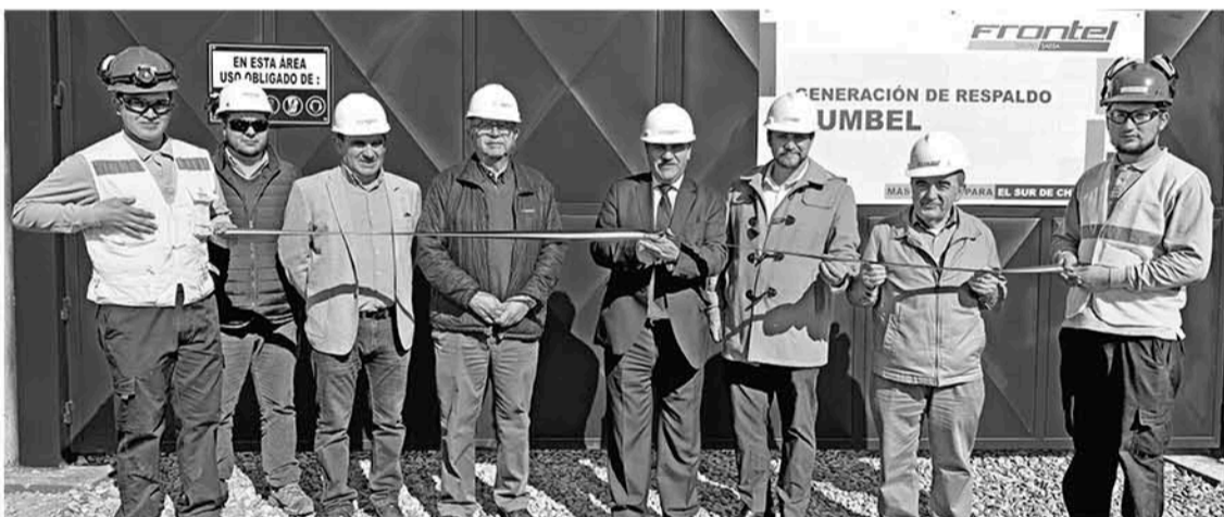
LA EMPRESA FRONTEL y la comunidad inauguraron el generador, que permitirá tener electricidad en caso de corte.
