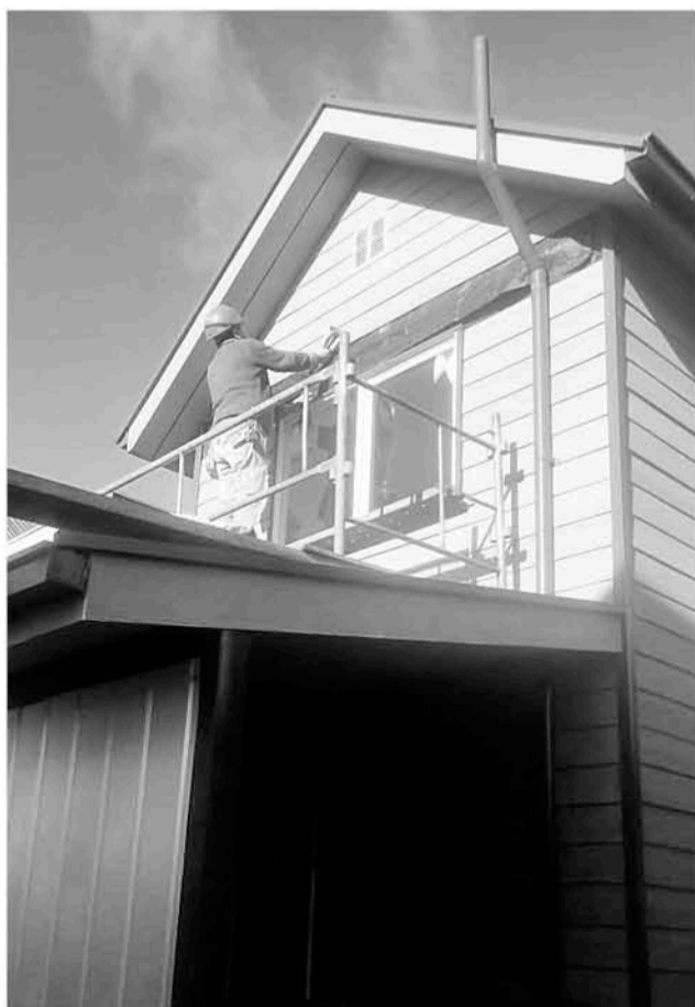
OTRO PUNTO EN EL QUE HAN INVERTIDO es en la instalación de ventanas de termopanel para lograr una mejor eficiencia térmica.
