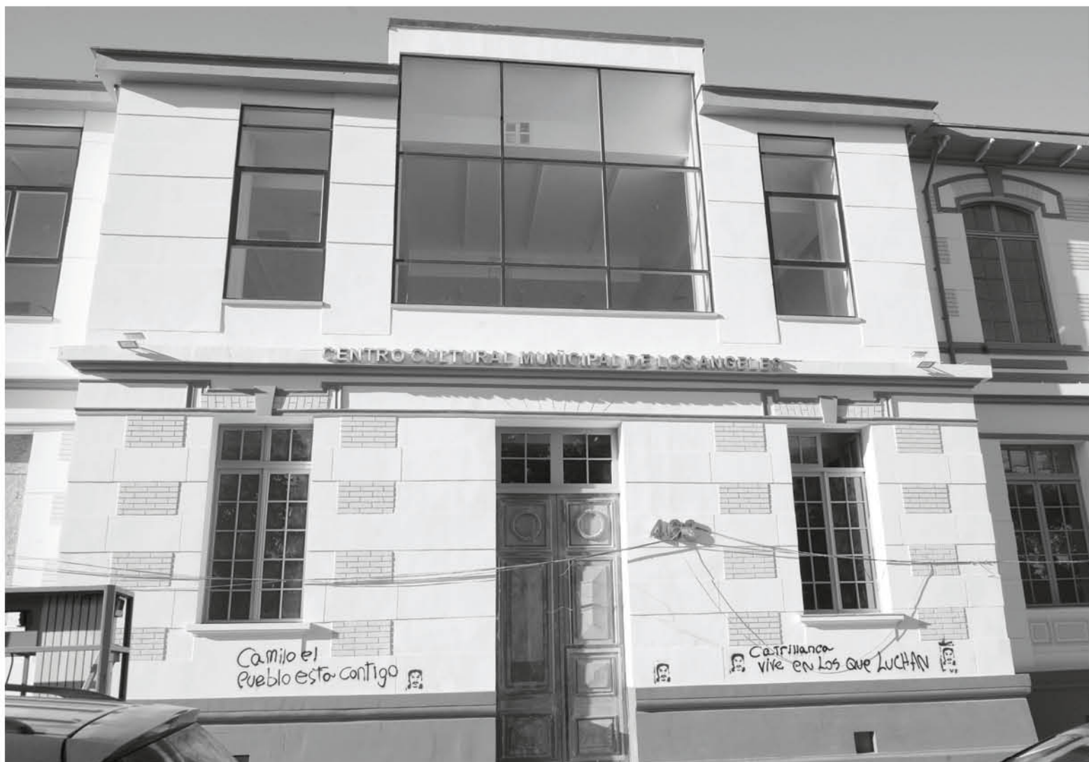
LA NUEVA CONSTRUCCIÓN será entregada entre los meses de enero y febrero del próximo año.
