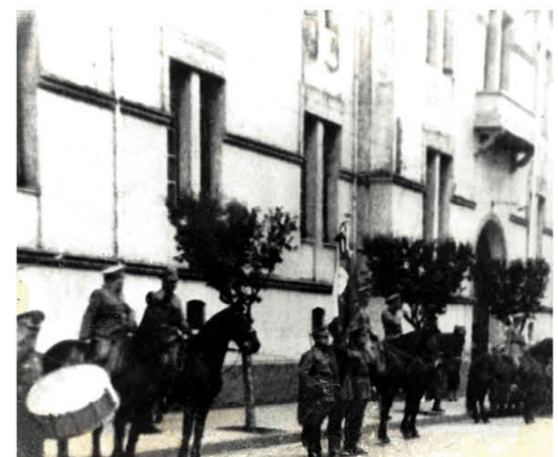
PUERTA DE ACCESO al actual destacamento N° 17 “Los Ángeles” al final de la calle Ercilla.
