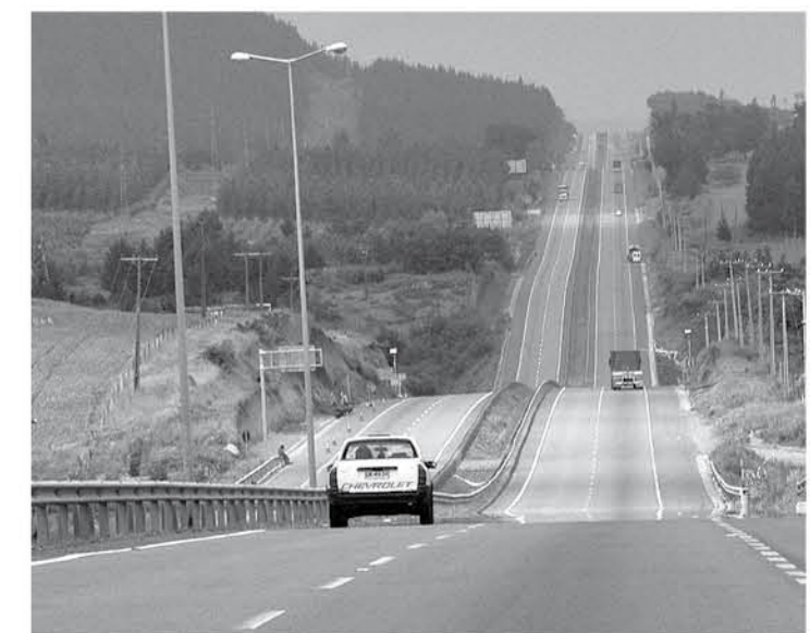
VISTA GENERAL de la Ruta Cinco Sur hacia Mulchén.
