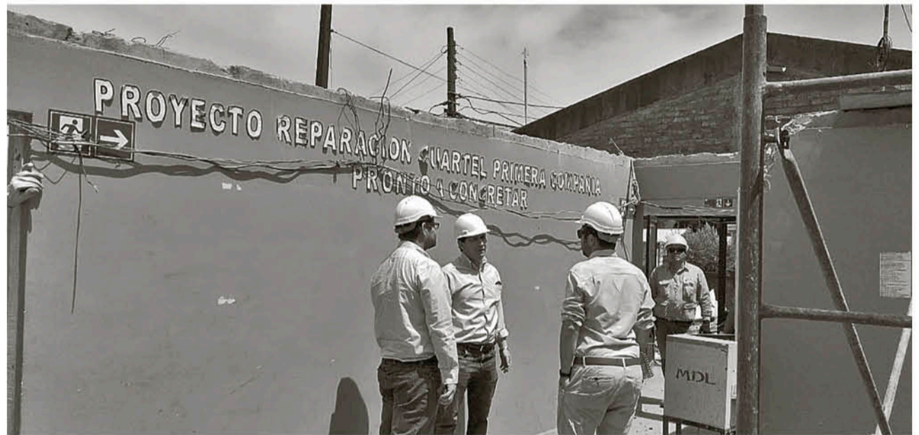
CON DAÑOS SEVEROS quedó el Cuartel de Bomberos a consecuencia del 27/E.
