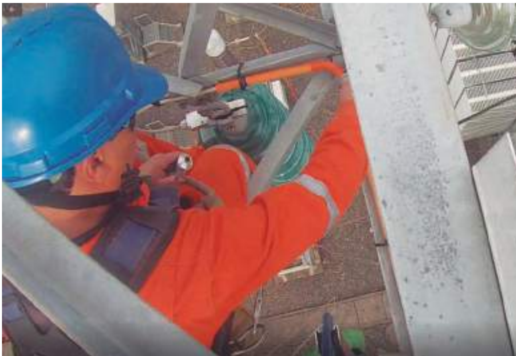
► Instalación de prototipo final desarrollado en Subestación Eléctrica Temuco, propiedad de Transelec S.A..
