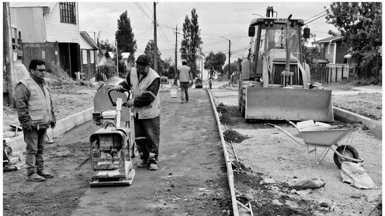
UN TOTAL DE 7 MIL 955 MILLONES serán invertidos en la región para el mejoramiento de numerosos pavimentos. La comuna de Los Ángeles fue la más beneficiada.
